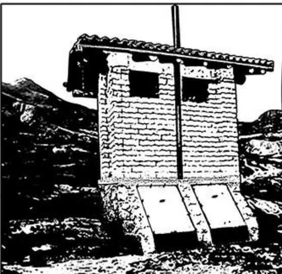
Tenemos el baño seco que tiene dos cámaras intercambiables que cuando se llena una se deja compostear un año, que después sale abono para las plantas. Se ha visto la diferencia con un baño de agua, por ejemplo una persona al menos se gasta 9 litros al día por ir al baño, si eso lo multiplicamos por una familia, una comunidad, o por todo el mundo, se gasta una gran cantidad de agua.
